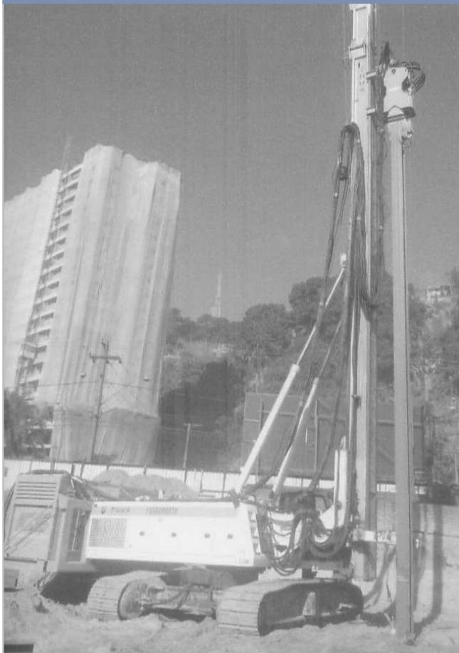
**Fotografia 8: Martelo vibratório elétrico**
