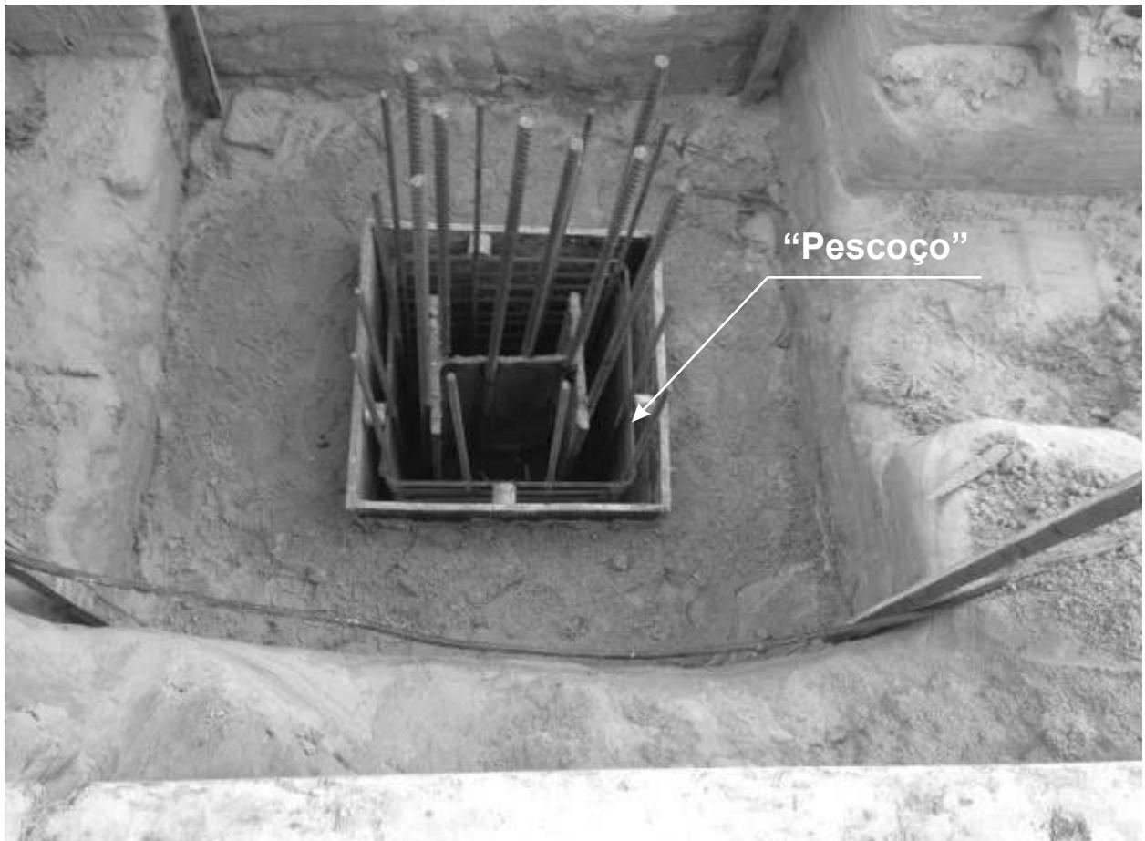
O detalhe apresentado na Figura 10 e na fotografia 5 pode ser utilizado como referência para outros grupos de perfis. Normalmente concreta-se inicialmente o “pescoço” antes do bloco de coroamento, retira-se a forma do pescoço, aterra-se com compactação o solo à sua volta e finalmente executa-se o bloco de coroamento.
