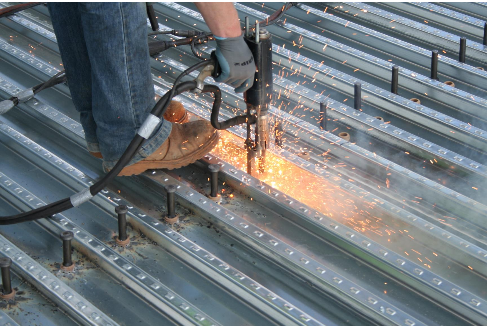
Fixação do Steel Deck – STUD BOLTS
