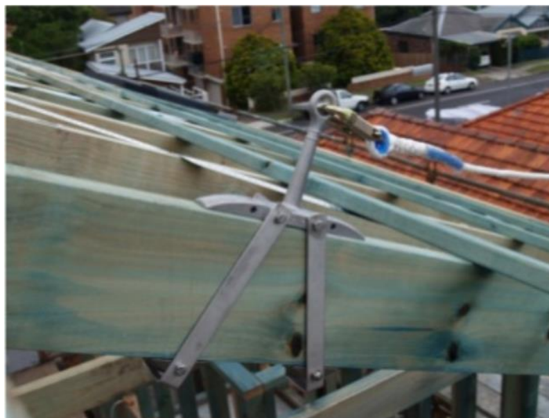
Figura 4 – Tipo A2 – Exemplos, não exaustivos, de dispositivos de ancoragem desenvolvidos para serem instalados em telhados inclinados
