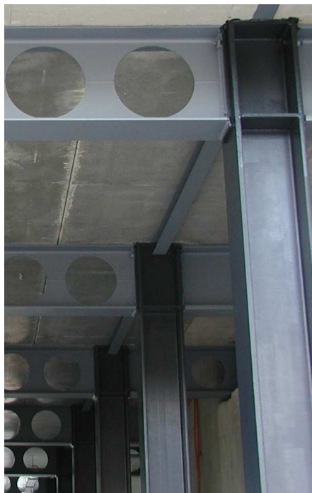
Figura 16: Ligação viga-pilar
