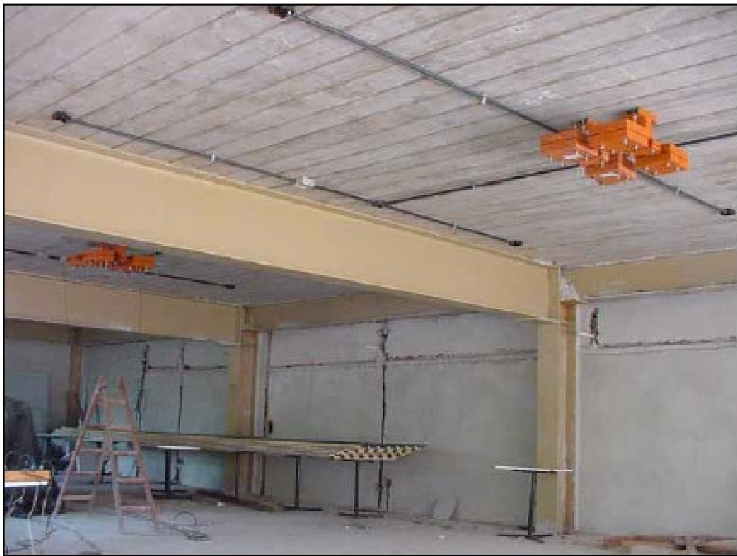
Figura III.11 - Conjunto de ADS projetados por BATTISTA [80,100] e instalados na estrutura.
