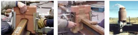
Montagem de um sistema para soldagem de trilhos
